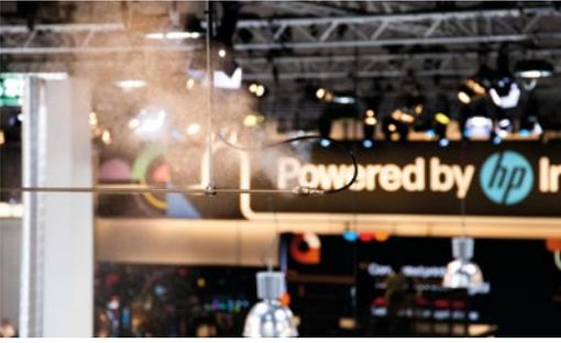
Über 200 installierte Düsen sorgten in der HP-Halle 17 für optimale Luftfeuchtigkeit.
